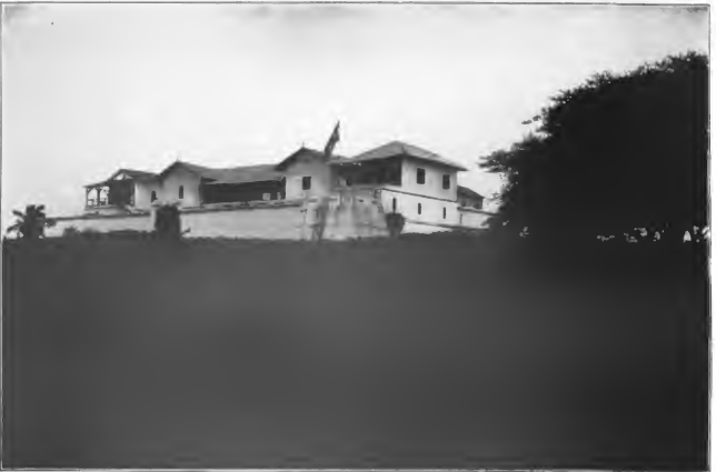
Boma der Station Kilimatinde von Nordosten. Vorn Offizierhäuser, dahinter Unteroffizierhaus (Deutsch-Ostafrika).
